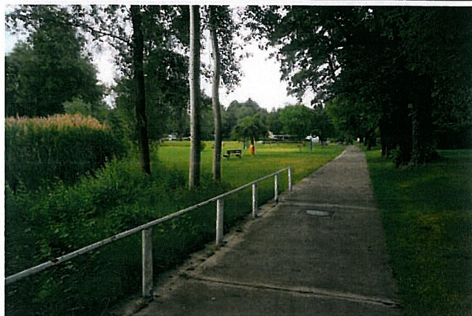
Verdolung des Kaitzbaches im Naturbad Mockritz, Nutzung als Weg, im Hintergrund der Liegewiesenbereich
